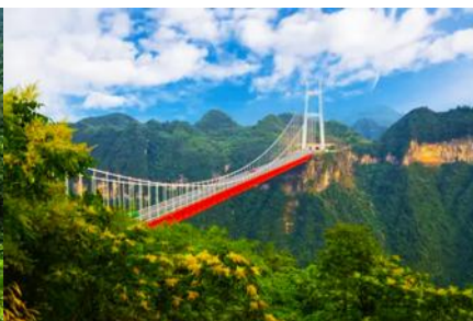
สะพาน ไขว้ายต้าเจียว
