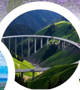
สะพานกัวจื่อโก
